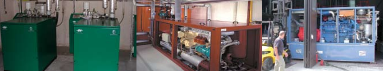
Motor für BHKW, elektrische Leistung von 611 kW, thermische Leistung von 800 kW, Gasmotor für Fernwärmeversorgung, Sossenheim, Frankfurt, Deutschland.
