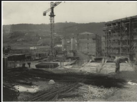
Construção do bairro social de Santa Tecla Construction of the Santa Tecla social housing estate
