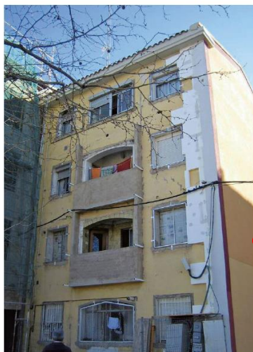
Fotografía: J. Rubio (Sara Maynar, 4-6, Grupo Pizarra, Zaragoza) Proyecto de rehabilitación: Ollano, Mondo y S. María, Arquitectos
