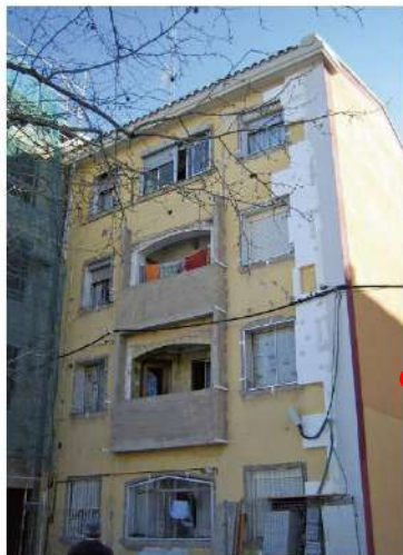
Fotografía: J. Rubio (Sara Mayra, 4-6, Grupo Pinaral, Zaragoza) Proyecto de rehabilitación: Olano, Mendo y S. María, Arantxokoze
